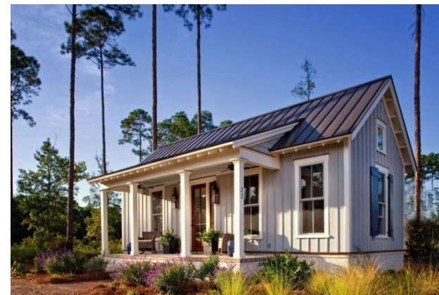
metalen dak, houten bekleding
