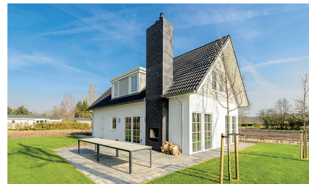
donker dak, beneden stucwerk
