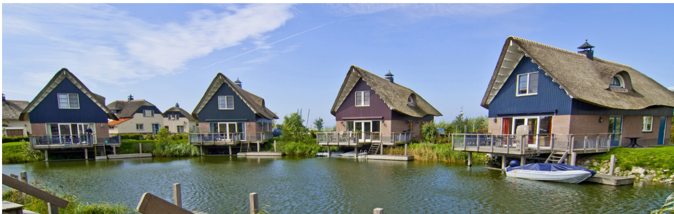
rietens kap, metselwerk begane grond, daarboven hout
