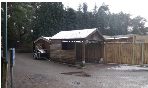
foute locatie carport vooraan op het terrein, te hoge terreinafscheiding
