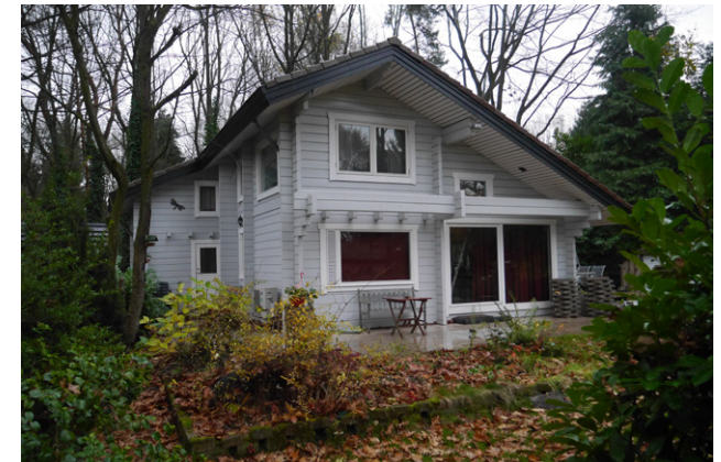
uitbreiding linksboven op de verdieping
